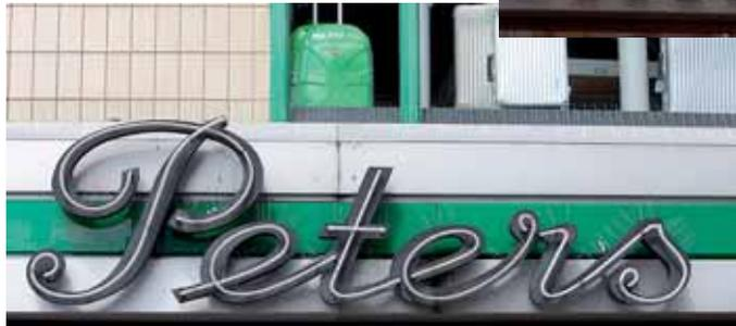
lich alle Schriften „gebaut“ werden können. Die Umrisse werden maschinell aus leichtem Blech geformt und dann mit passenden Vorder- und Rückseiten versehen. Soll der einzelne Buchstabe aus sich heraus leuchten werden heute
